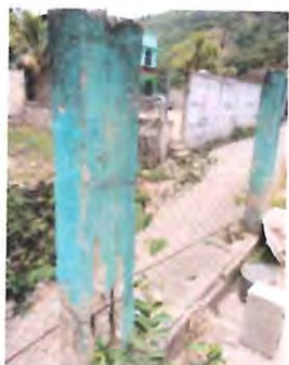
REPARACION DE REPELLO Y CERNIDO EN COLUMNAS
