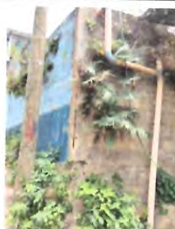
SUSTITUCION DE BAJANTES PLUVIALES
