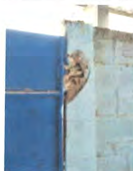
REPARACION REPELLO Y CERNIDO EN MURO DE INGRESO
