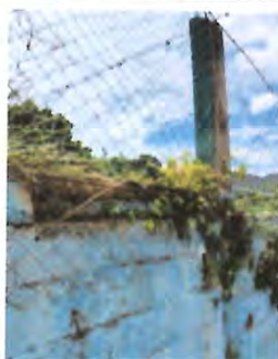
REPARACIÓN DE MUROS DE CONTENCIÓN Reparación de fisuras y grietas en la estructura
